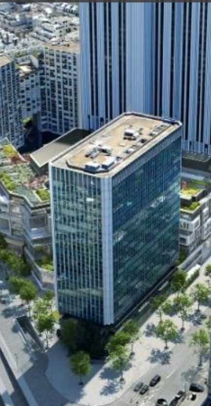
UN QUARTIER RÉINVENTÉ Gare rénovée
